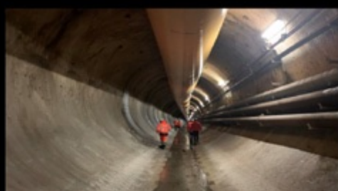
ASSISTENZA AMBIENTALE DI CANTIERE
